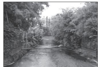
บ่อล้างล้อรถบรรทุกก่อนออกสู่ถนนสาธารณะ
